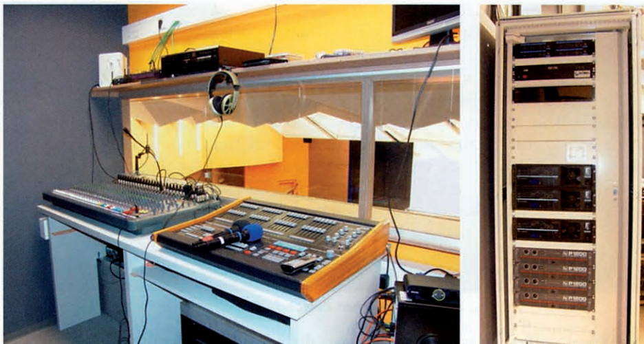
Links: Blick in die Tonregie, rechts: Audiorack mit Biamp Nexia und alcons audio System-Amps
